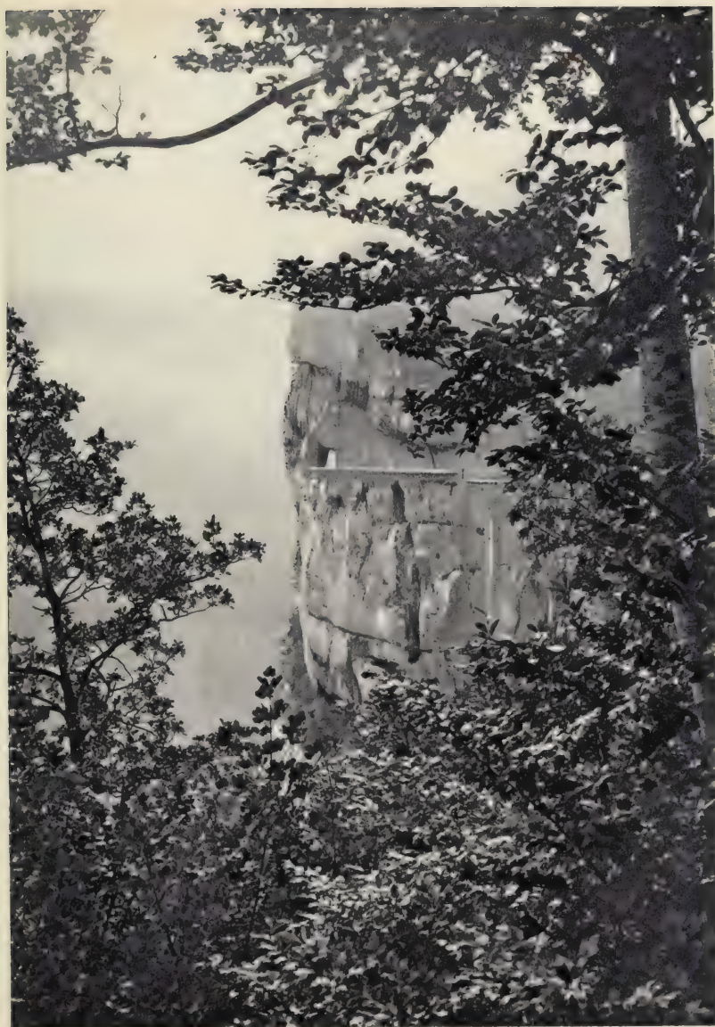
Route de Combe Laval : le premier tunnel.
